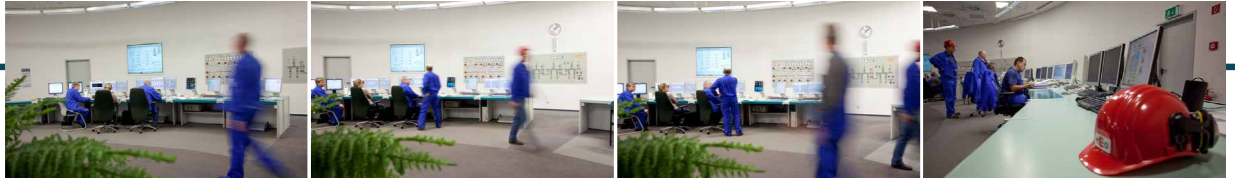
Die Netzleitstelle der VEO sichert Eisenhüttenstadt und die Umgebung.
